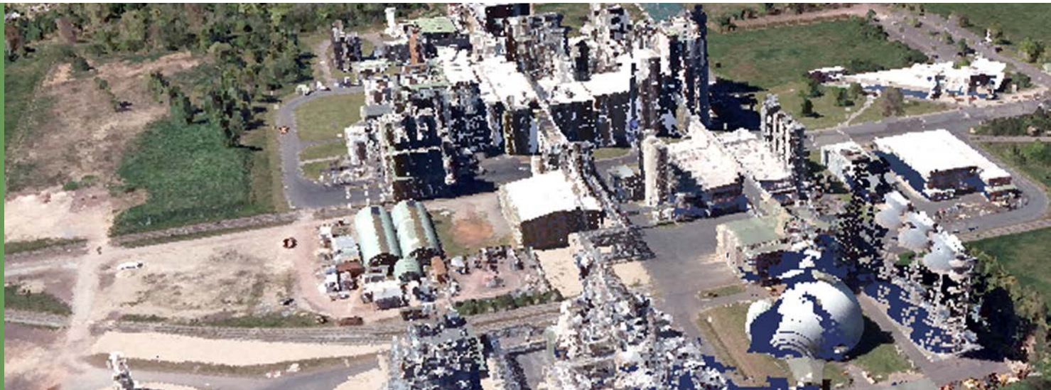
DOM, Industrieanlage bei Barby (Elbe)
