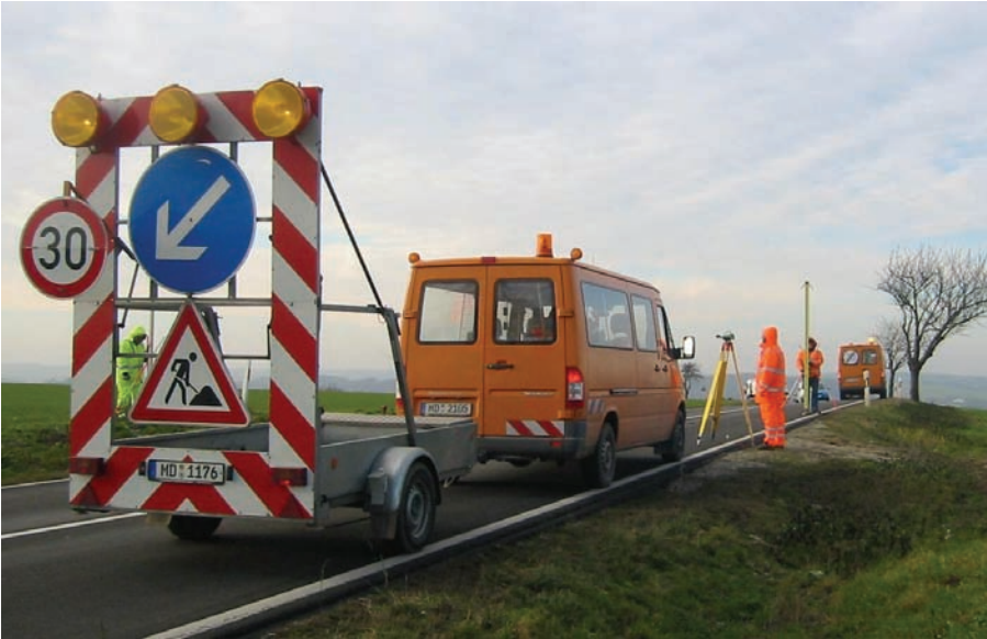
Abb. 3: Niv-Trupp mit Sicherungsfahrzeugen beim Nivellieren
