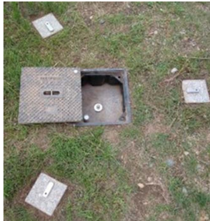
Abb. 6: Rammstabvermarkter Sicherungspunkt mit Schutzkasten und Stativfußvermarkung (Foto: Heiko Sievers)
